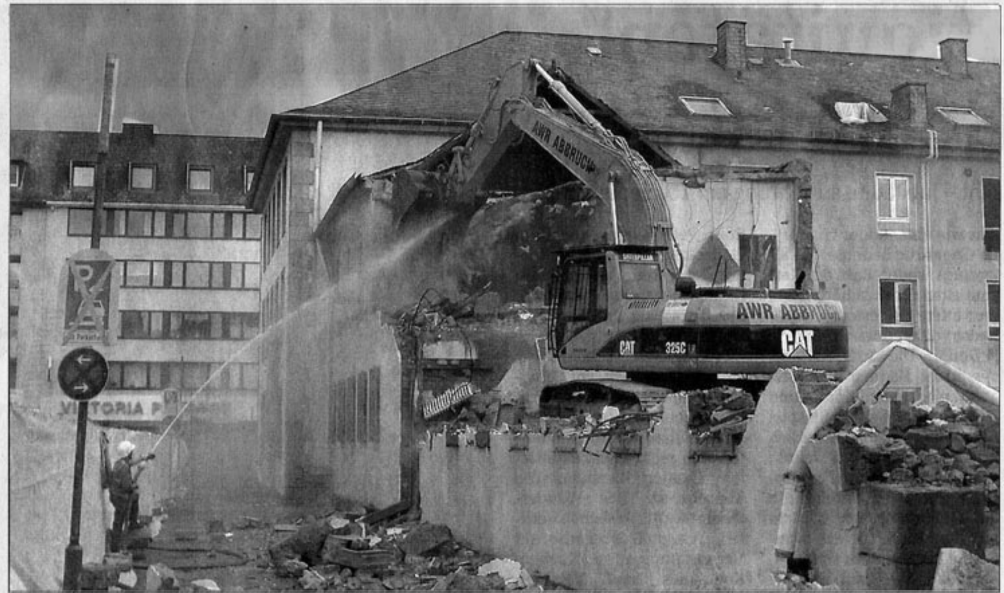
Das ehemalige Rodenwaldt-Institut soll im laufenden Jahr verschwinden. Ein Gebäude an der Luisenstraße wurde bereits abgerissen.
