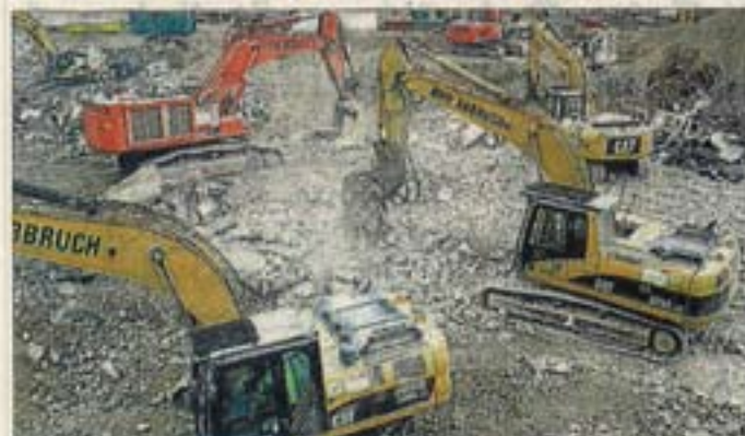
Zehn große Maschinen sind auf dem Zentralplatz zugange: Sie brechen das Haus Stück für Stück ab (Foto rechts), sie sortieren und zerkleinern den Beton (links unten) und bauen den Platz schon wieder auf. ■ Fotos: Jennifer Wallburger
